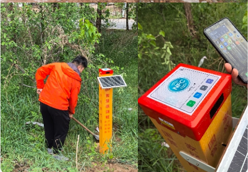
项目名称：管网小型三方施工监测 项目地点：山东.日照
