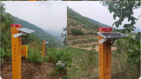
项目名称：管线水保工程监测 项目地点：山东.济南
