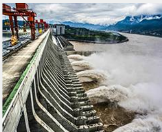
水库大坝监测
