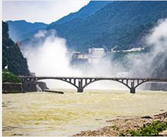
桥梁沉降监测
