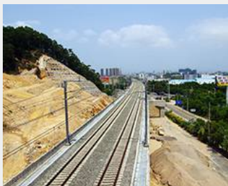
铁路沉降监测
