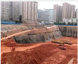
基坑位移沉降监测
