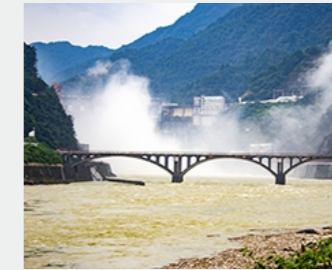
桥梁沉降监测
