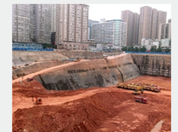
基坑位移沉降监测
