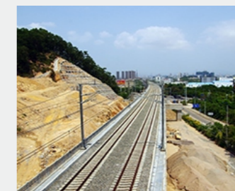
铁路沉降监测
