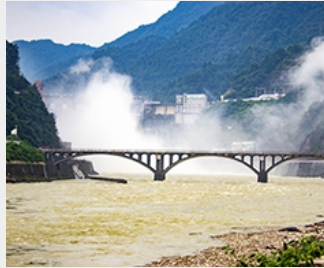
桥梁沉降监测
