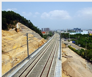
铁路沉降监测
