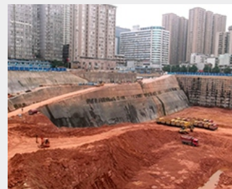
基坑位移沉降监测
