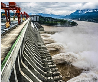
水库大坝监测
