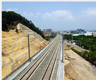
铁路沉降监测
