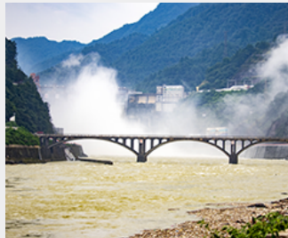
桥梁沉降监测
