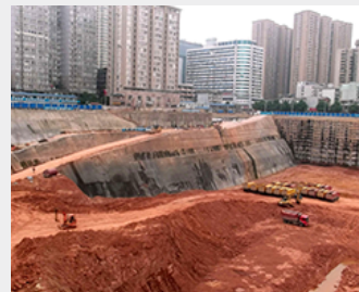
基坑位移沉降监测
