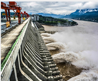
水库大坝监测
